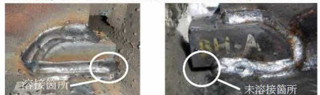
写真 1 鋼片挿入の隅肉溶接周辺写真
