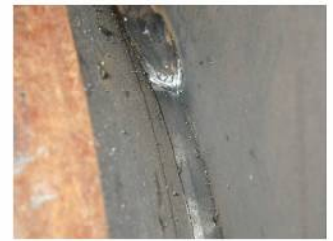
写真 2.1 組立て溶接の外観
