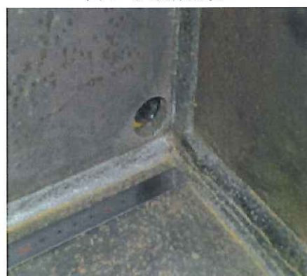
写真1 隅角部の溶接後外観の例
