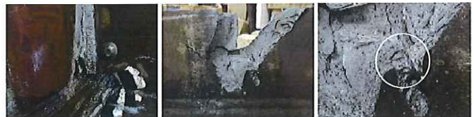
a) 破壊性状 b) ウェブ側破面 c) 柱側破面 写真 2 RS_W 試験体の柱-ウェブ接合部の破壊性状
