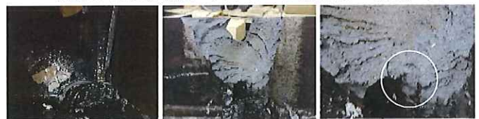
a) 破壊性状 b) web 側破面 c) 柱側破面 写真 3 RS_P80_W 試験体の柱-ウェブ接合部の破壊性状
